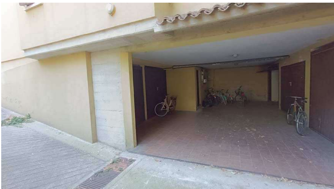
006 - PARTICOLARE ACCESSO AUTORIMESSE
